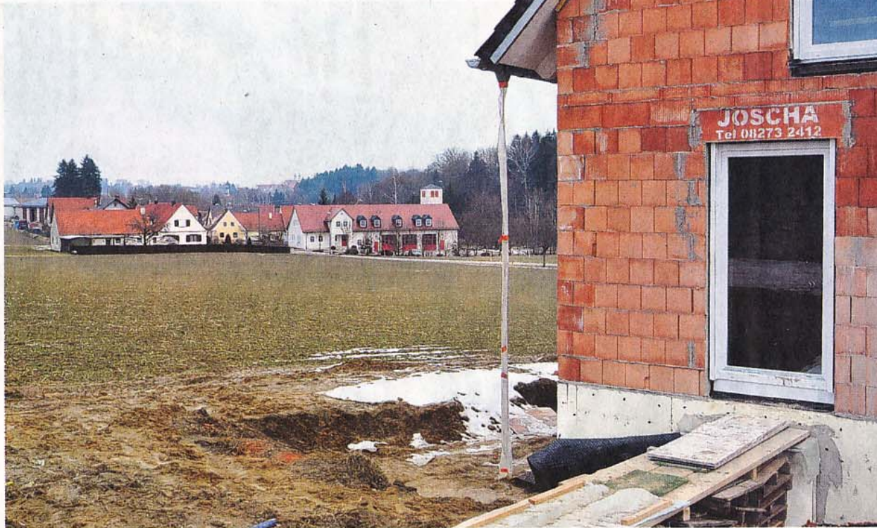
Zwischen dem Ortsrand und dem Neubaugebiet Badfeld II soll die Gasleitung „Monaco“ in Ehingen verlegt werden. Dagegen regt sich Widerstand.
